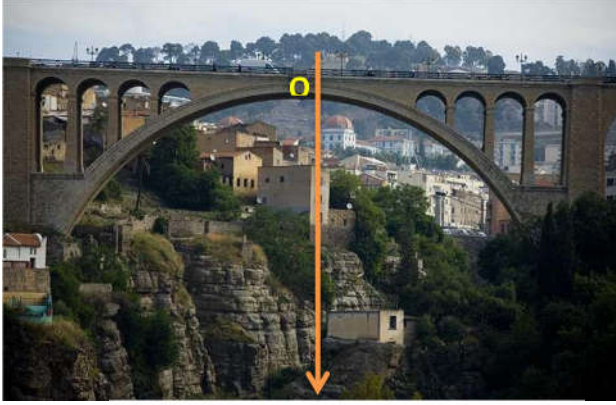
الشكل (1) جسر سيدي راشد
